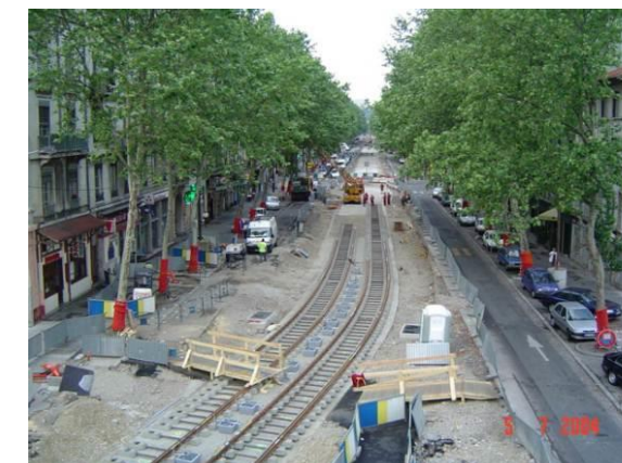
Figure 6 : Mise en place des rails
