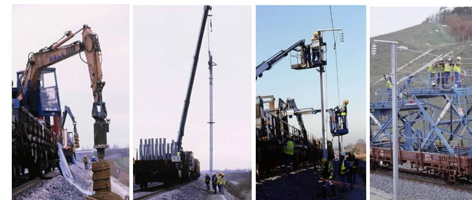
Figure 8 : les différentes étapes de pose de la LAC (Source : étude d'impact sur l'environnement TTNC)
