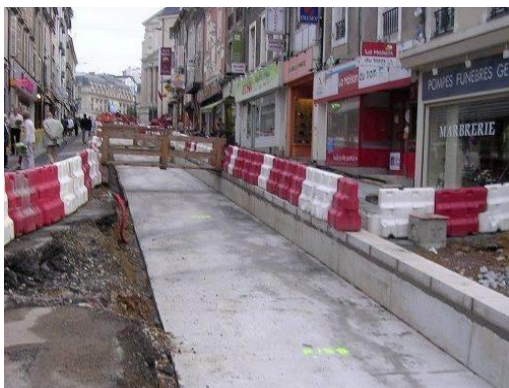
Figure 2 : Cheminement piétons préservés pendant le chantier du tramway du Mans
