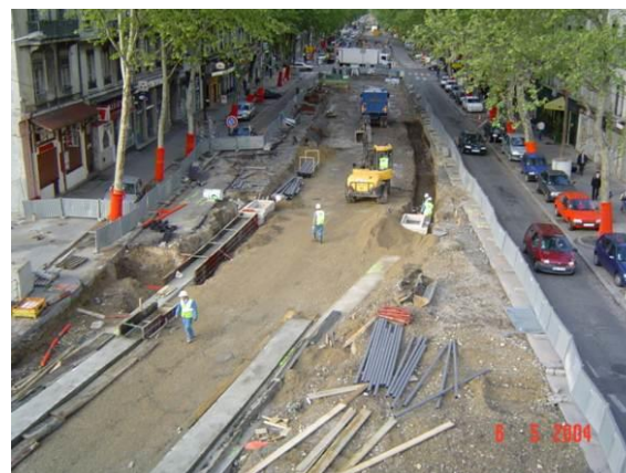
Figure 5 : Travaux de terrassement pour l'aménagement d'une ligne de tramway
